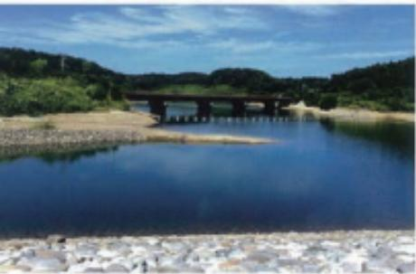
後谷ダムは柏崎市西山町に1993年に着手、2008年に竣工したゾーン型フィルダムというタイプのダムです。ゾーン型フィルダムとは土と岩を盛り立たるもので、地盤強度が弱く変形しやすい土地に対応すること
