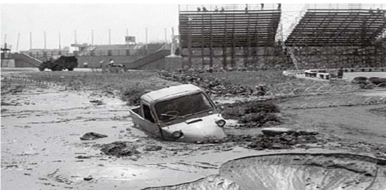
場 所 : 新潟県新潟市中央区 撮 影 : 国立防災科学技術センター 撮影日 : 1964年6月17日
