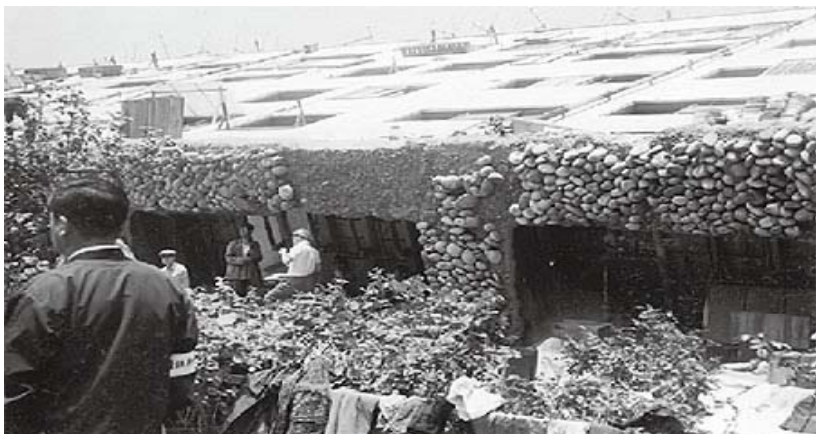
場 所 : 新潟県新潟市川岸町 県営アパート 撮 影 : 国立防災科学技術センター 撮影日 : 1964年6月18日12時頃
