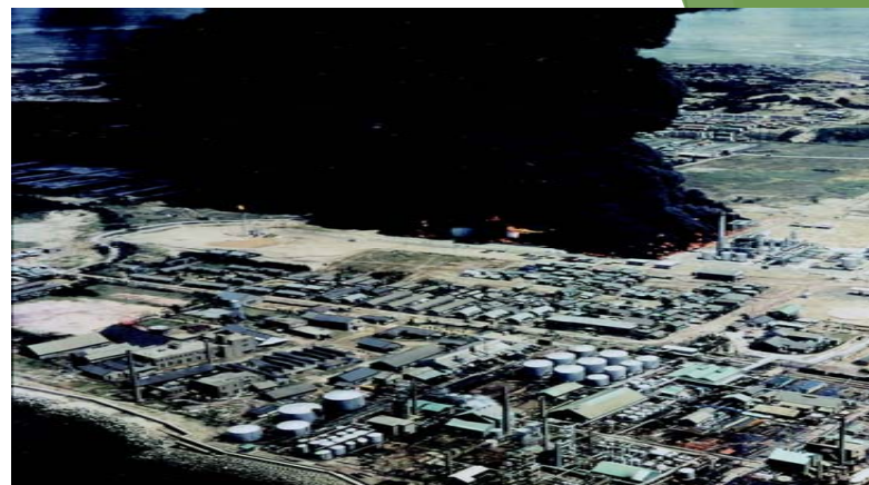
場 所 : 新潟県新潟市臨港町付近、昭和石油 撮 影 : 弓納持福夫氏 撮影日 : 1964年6月16日地震発生後 出典元 : 個人撮影
